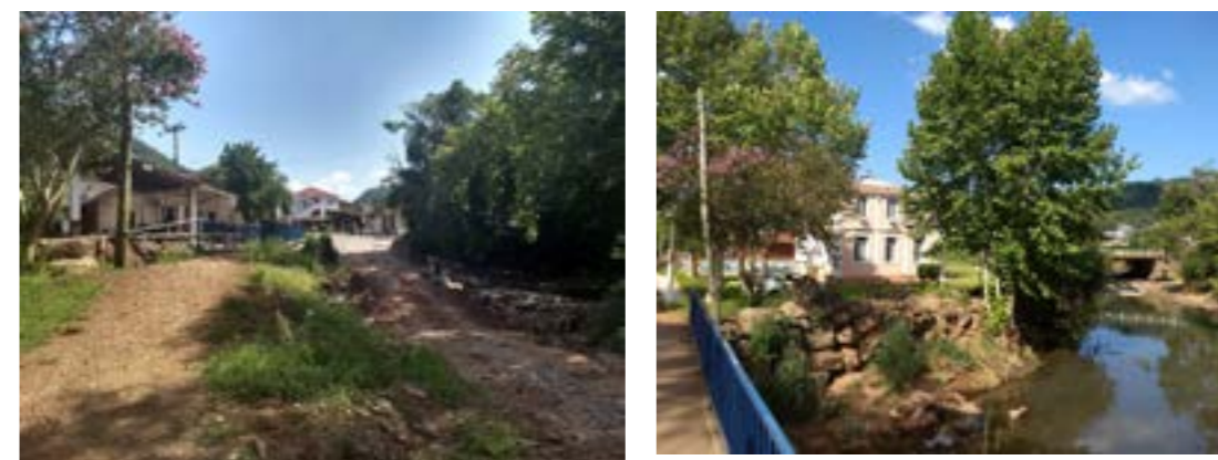
Figura 11: (a) Passagem em dois níveis: para pedestre por pontilhão, e para automóveis em nível mais baixo, sobre aterro com tubos; (b) Ambiente sobre aterro com tubos; (b) Ambiente que se diferencia da área urbana. Fonte: da autora, 2018.
