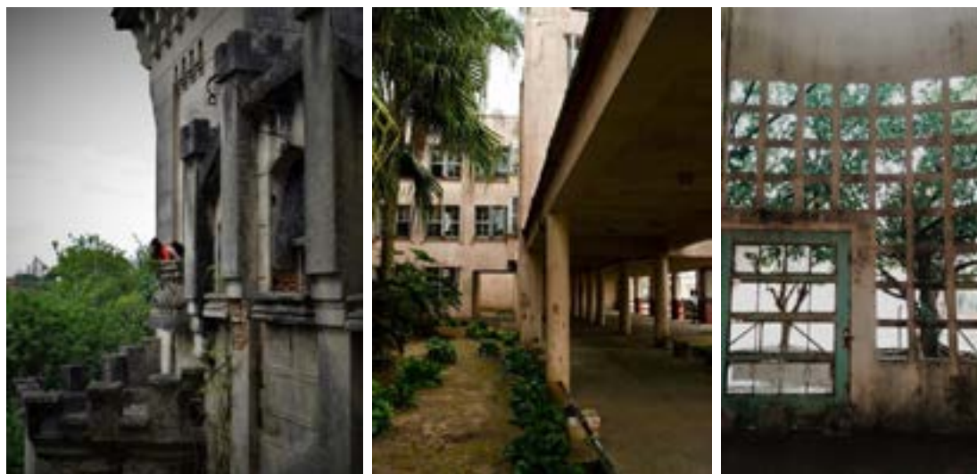
Figuras 7: (a) Castelo Simões Lopes Neto (b) interior do Edifício IPASE, em Pelotas (c) Antiga Caixa d'água de Pelotas. Fonte: dos autores, 2017.
