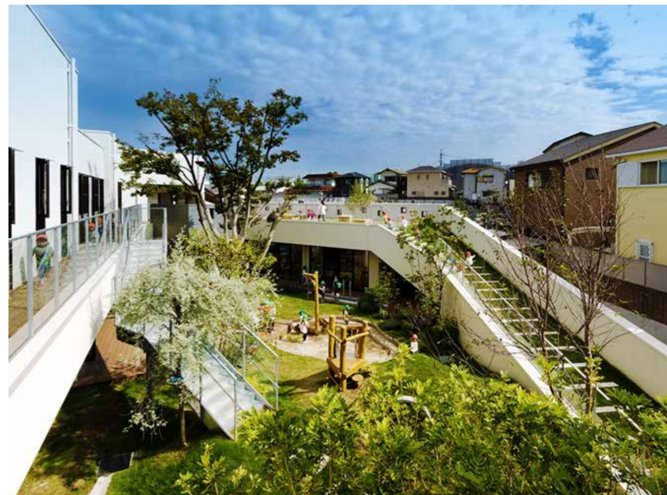
Figura 1 – Vista do Pátio Central. Fonte: Archdaily (2016).
