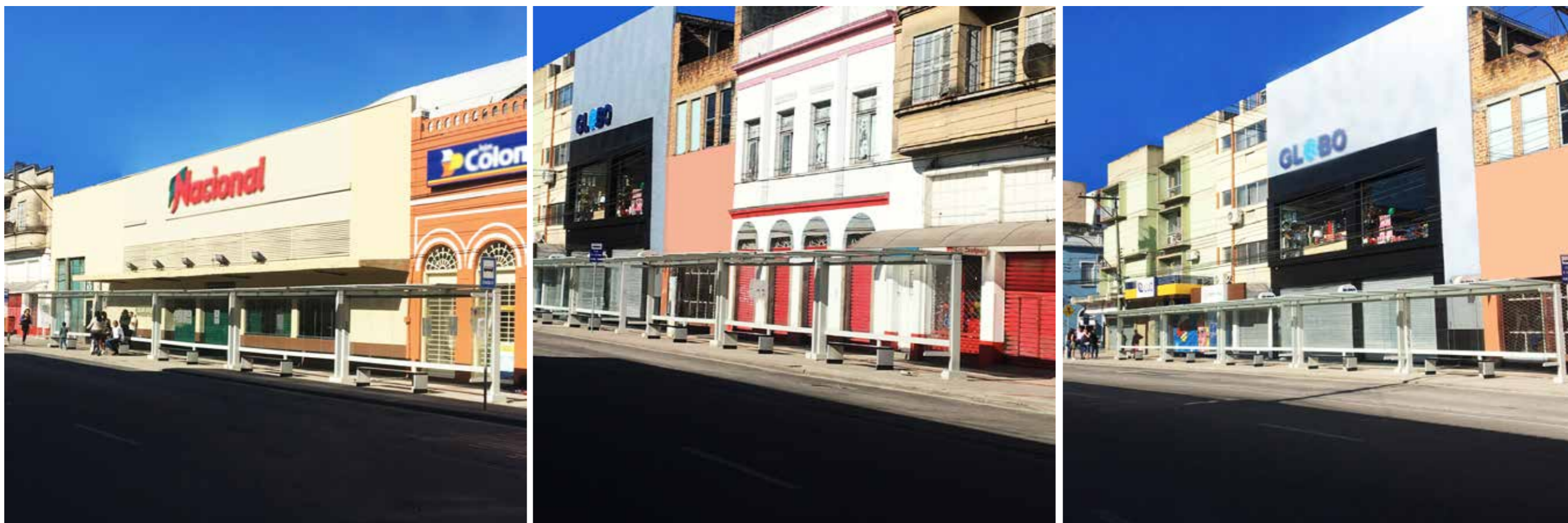
Figura 1 - Conjunto de abrigo de ônibus da rua General Osório. Fonte: Autor, 2018.
