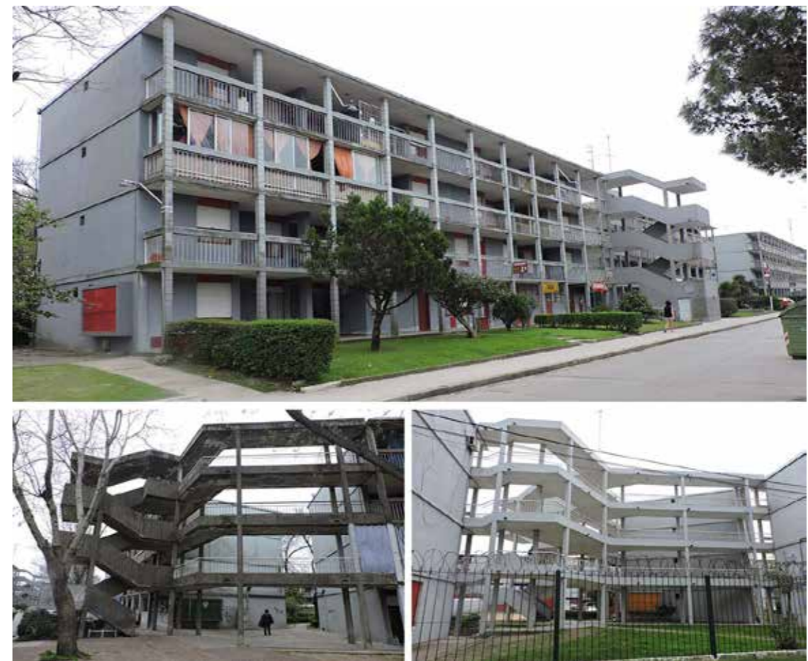
Figura 2 - Circulações horizontais (ruas elevadas) e verticais (rótulas de conexão). Fonte: Fotografias das autoras, 2018/19.
