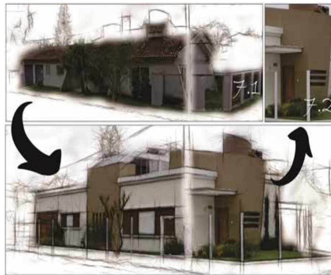
Figura 7 – Fachada da residência de esquina atual e anterior à reforma. Fonte: fotografia do autor, registrada em setembro de 2016, e Google Street View, obtida em fevereiro de 2017.
