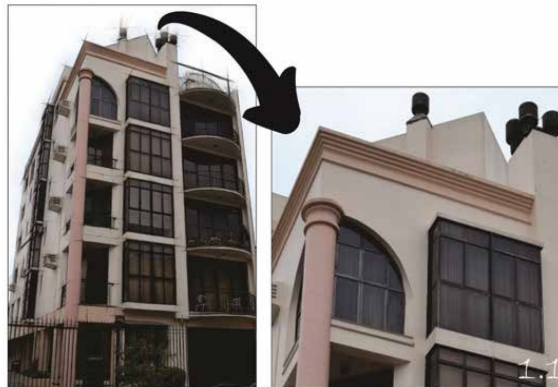
Figura 1 – Fachada do Condomínio Edifício Solar da XV. Fonte: fotografia do autor, registrada em setembro de 2016.
