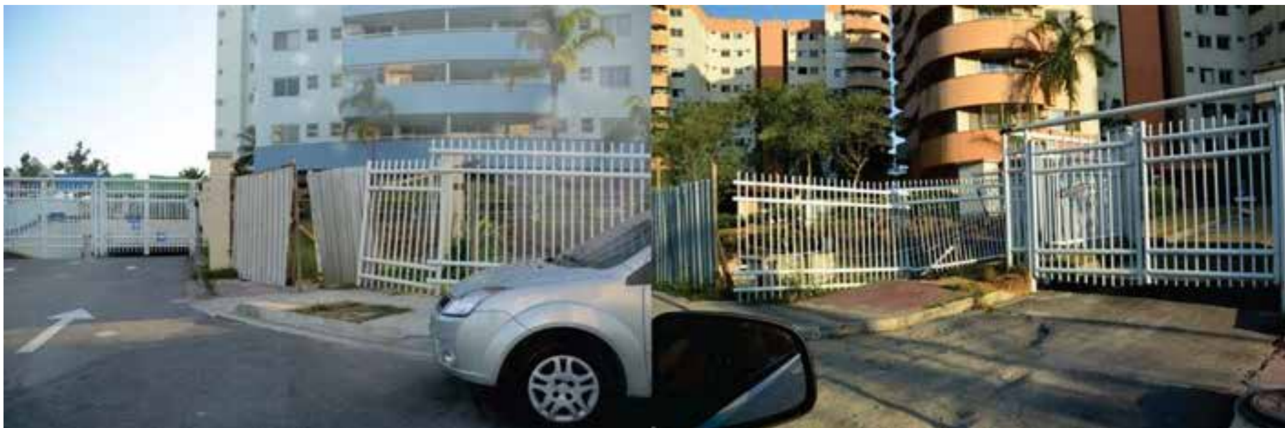
Figura 1 - Vila Pan-Americana e seus problemas estruturais. Fonte: Portella (2015).
