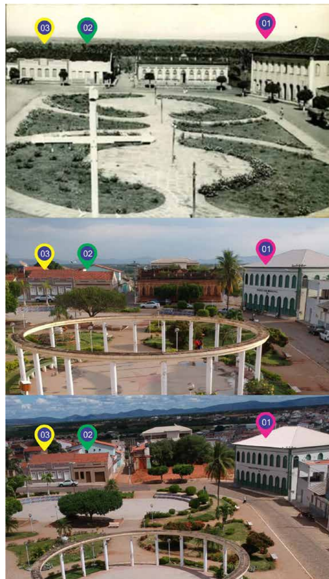
Figura 2 – Painel de construções edificadas no século XIX no Centro de Livramento de N a Sra., análise de permanências, 2021 e em 2022. Fonte: Acervo Pessoal de Higinio Santos e Vital Energia, elaborado pela autora, 2022.
