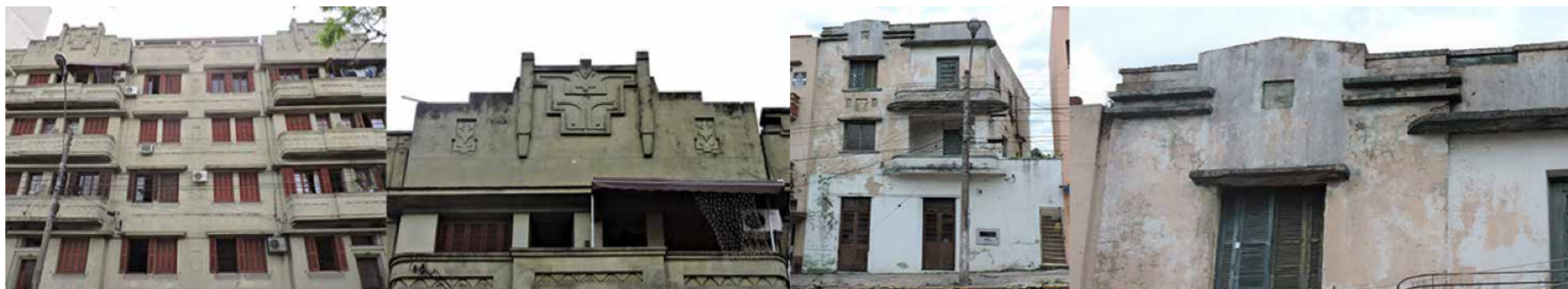
Figura 11 - Edifício Dr. Eduardo de Moraes, década de 1950, Santa Maria, RS. Fonte: Manuela Kelling, 2020. Figura 12 - Edifício Propriedade de Raimundo Cauduro, 1961, Santa Maria, RS. Fonte: Manuela Kelling, 2020.
