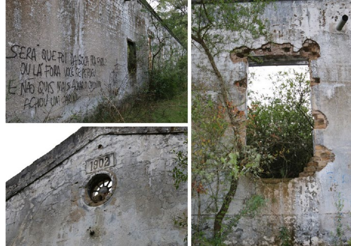
Figura 3 - Ruínas da antiga fábrica de línguas enlatadas Paysandú. Fonte: Acervo das autoras, 2019.
