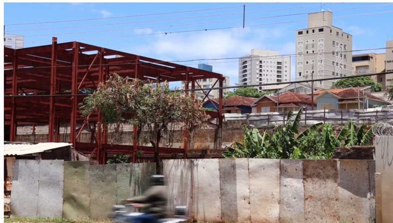
Figura 1 - Vista da estrutura inacabada abandonada e de seu entorno na região central da cidade de Londrina-PR. Fonte: As autoras, 2020.
