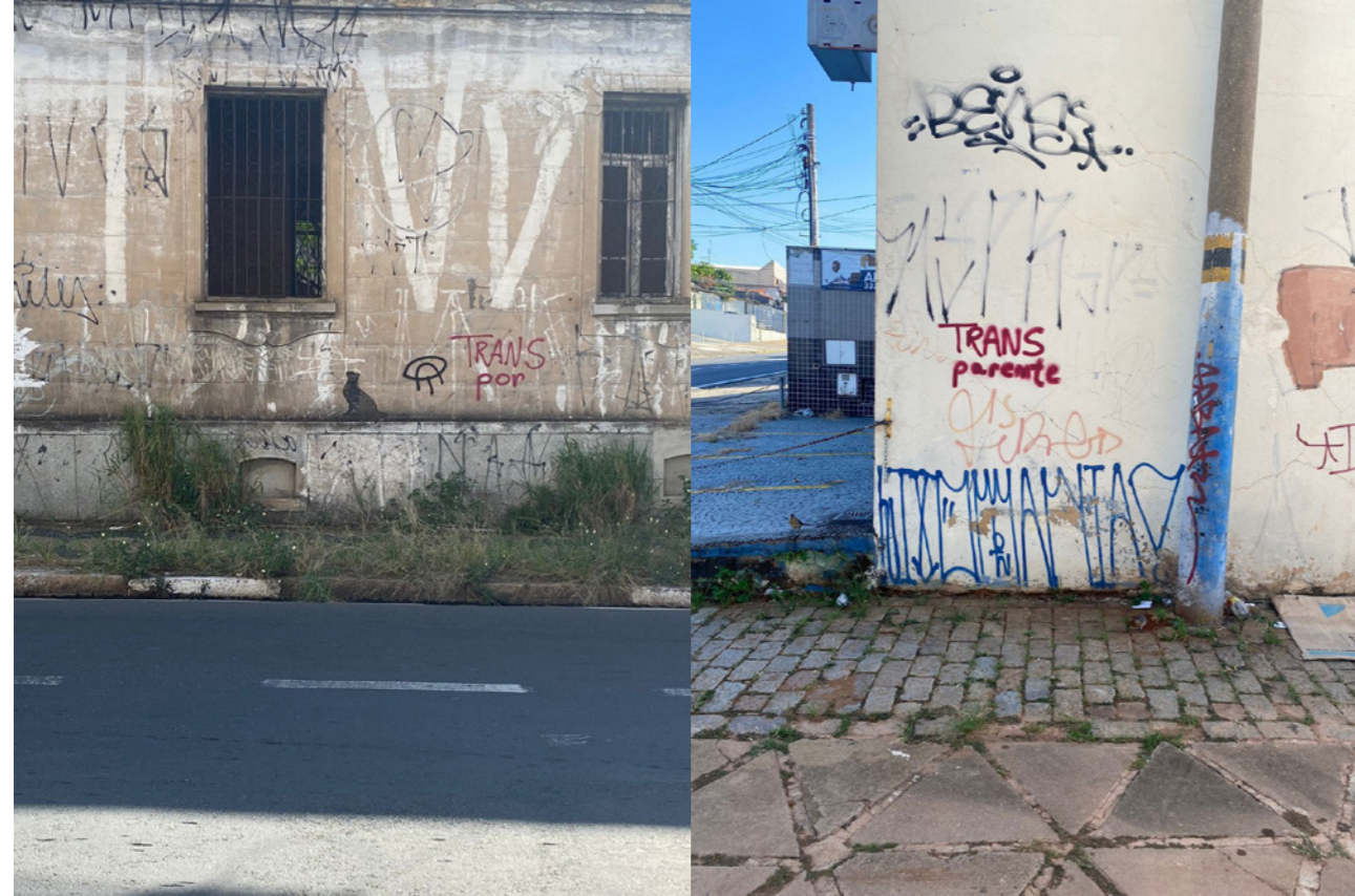
Figura 3 – TRANSpor: Muro de imóvel abandonado: R. Carolina Florence, 131. Fonte: foto das autoras. Figura 4 – TRANSparente. Muro de beco: R. Carolina Florence, 1472. Fonte: foto das autoras.
