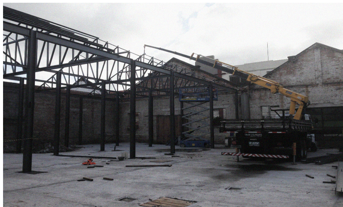
Figura 4 - Fase de obras: Relação entre as fachadas existentes e estrutura da cobertura atual. Fonte: Reitoria UFPEL, 2014. Figura 3 - Esquema em planta das áreas de modulação e preservação da edificação. Áreas demolidas (vermelho); Volumetria original mantida (azul); Volumetria original mantida - fachadas em desenho de lanternin (amarelo). Fonte: Autora, 2025.
