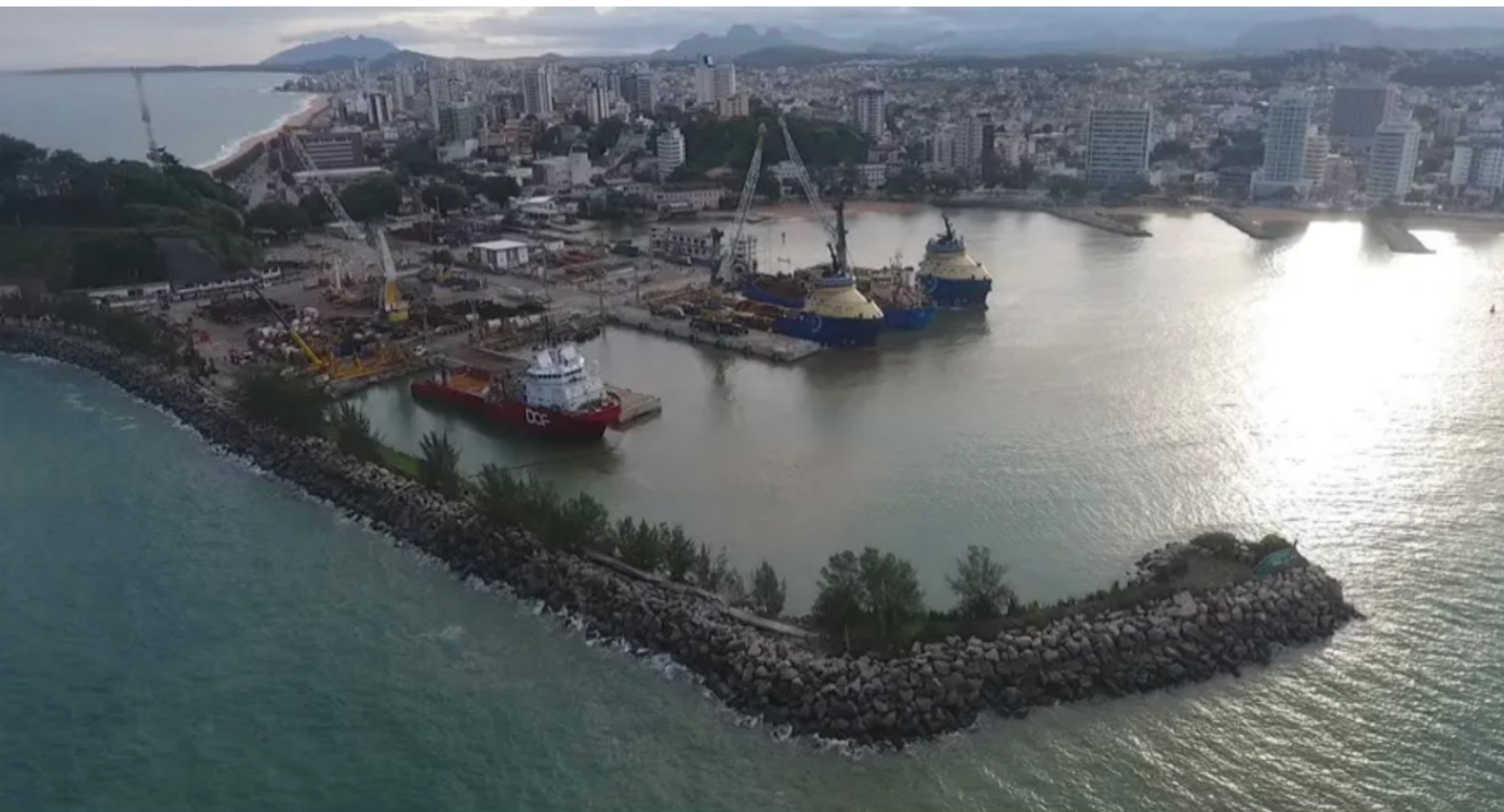
Figura 4 - Quebra-Mar do Porto Engenheiro Zephyrino Lavenère Machado Filho, Macaé – Rio de Janeiro. Fonte: Petrobras (2024).
