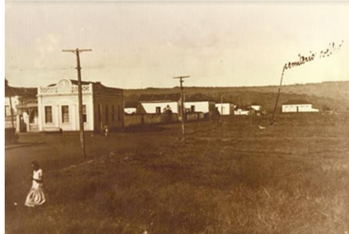
Figura 9 - Segundo Cemitério de Patos de Minas, hoje edifício do Fórum Olympio Borges. Fonte: Museu da Cidade de Patos de Minas.
