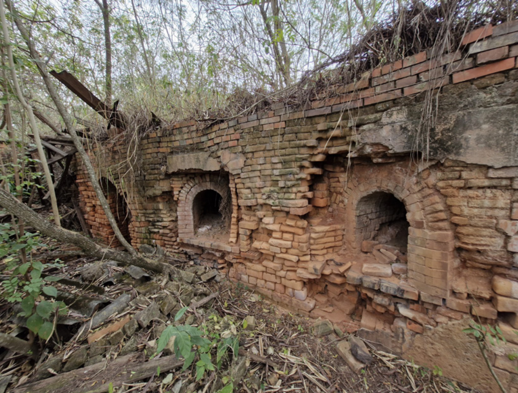
Figuras 13, 14 e 15 - Vestígios do forno de uma antiga olaria na paisagem mogiana, identificados pela autora em pesquisa de campo. As evidências revelam um saber técnico refinado, baseado no uso da argila local. Há indícios de que se trate da antiga olaria 'Cataguá', embora a identificação ainda não esteja concluída. Fonte: Fotos da autora, 2025.
