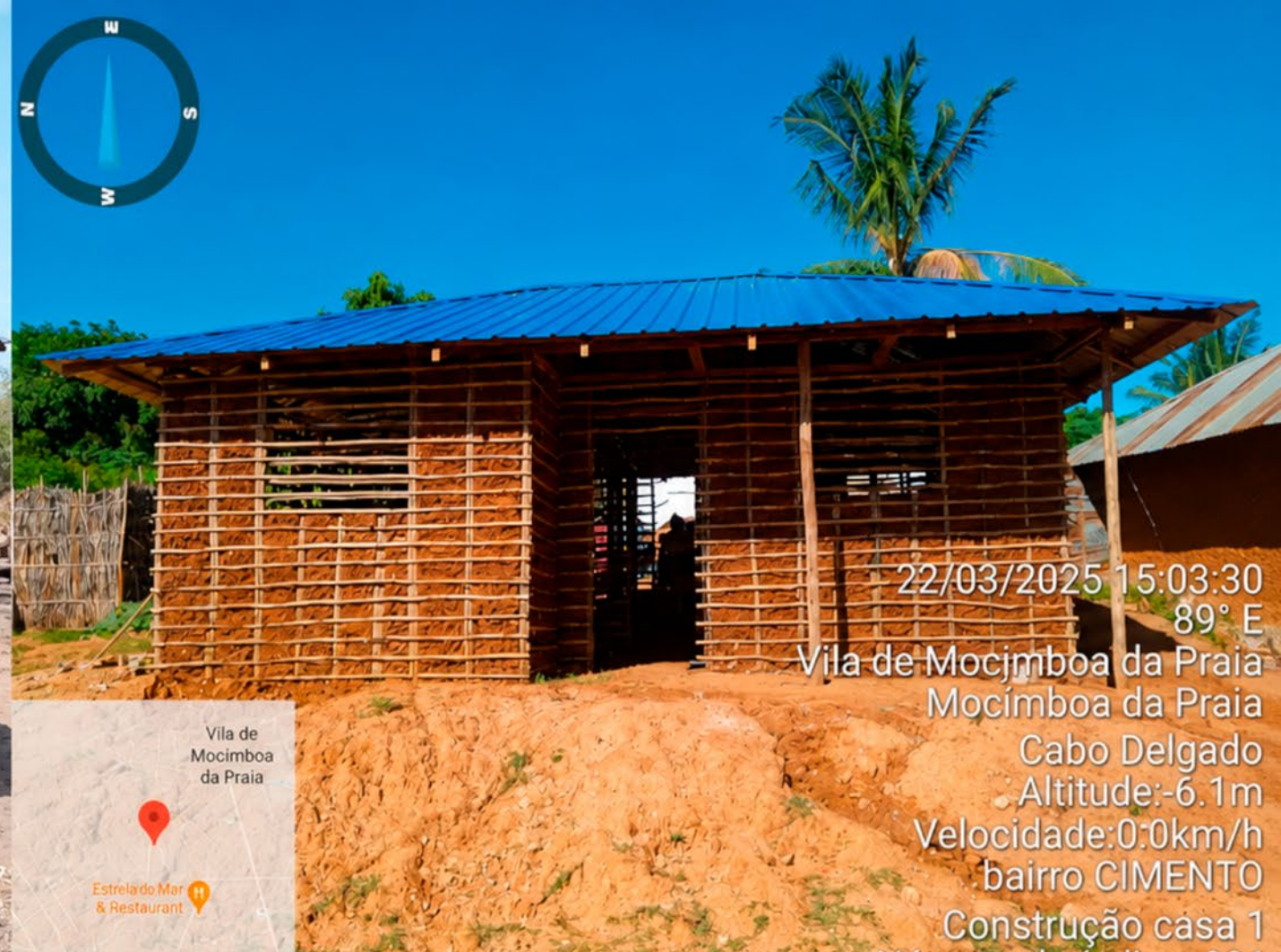
Figura 2 - Uso da técnica da taipa de mão. Fonte: adaptado dos entrevistados (Rahanito Antumane e Matilde Salomé), 2025.
