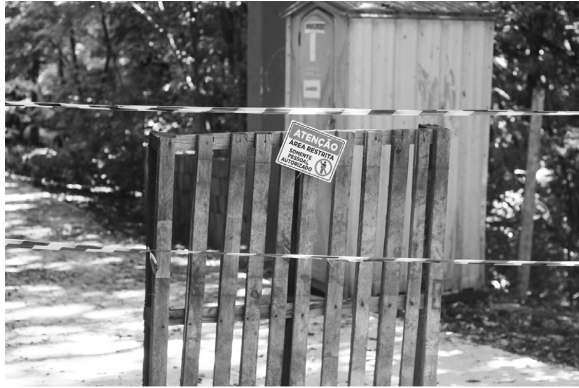
Figura 8 – Percurso no interior do Parque do Ingá, dia 26/11/2025. Faixas, cerca e placas impedindo o percurso para dentro do canteiro de obras do Jardim Japonês do Parque. Dos autores.
