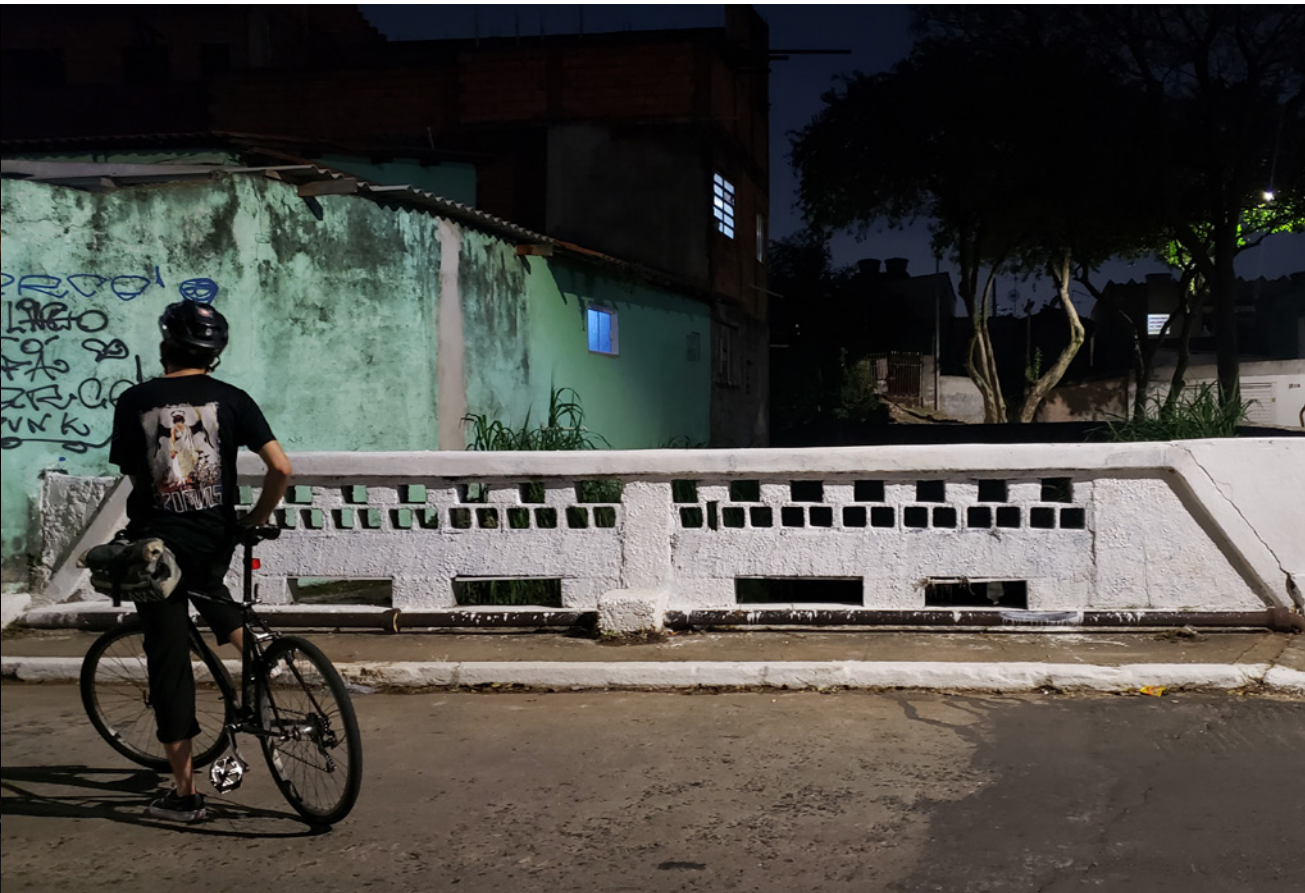
Figura 9 - Uma das pontes do córrego Ponte Rasa, no bairro Ponte Rasa, zona leste de São Paulo (SP), novembro de 2025. Fonte: da autora.
