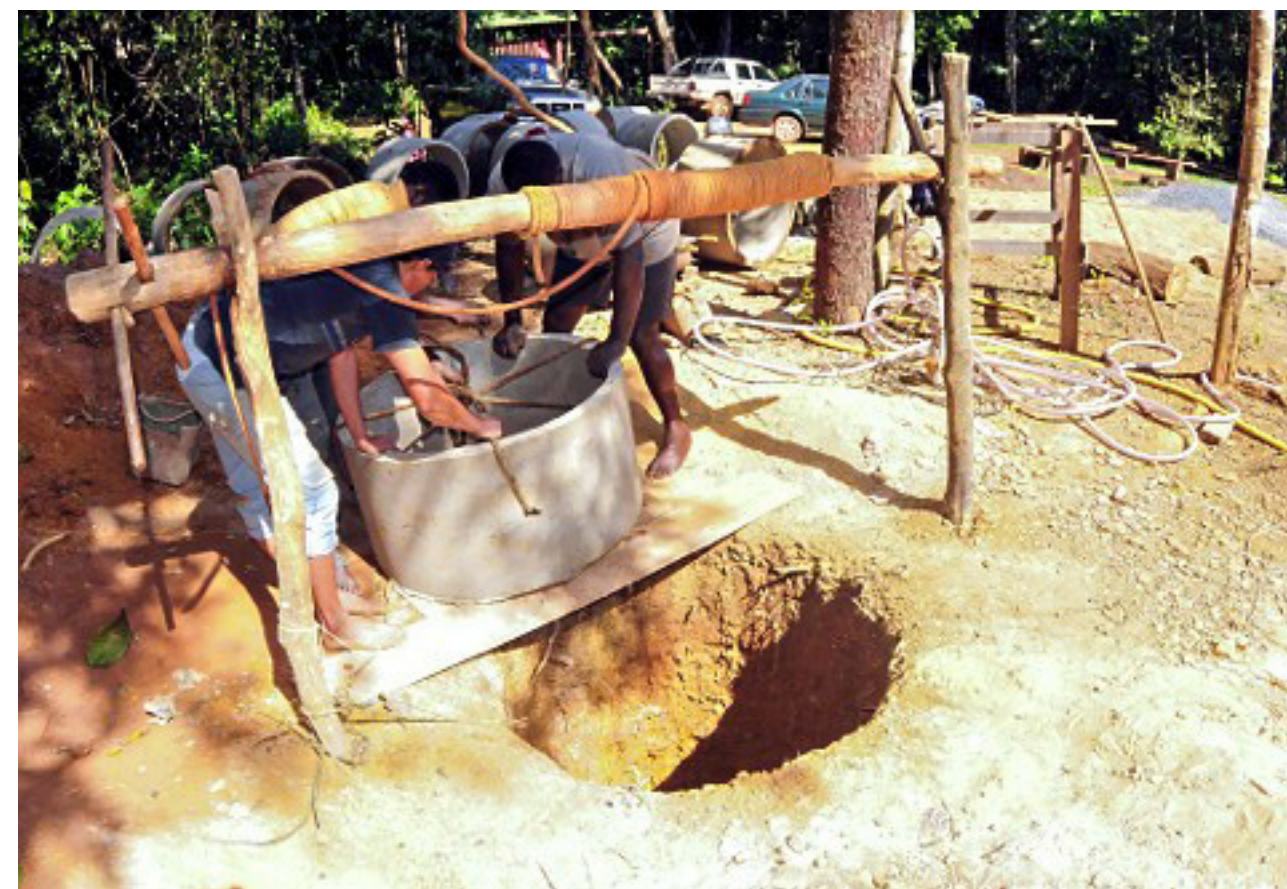
Figura 1 – Escavação manual de cacimba (imagem ilustrativa da técnica construtiva) Fonte: Banco de Imagens Pulsar (Chapada dos Guimarães, 2015). Disponível em: pulsarimagens.com.br .
