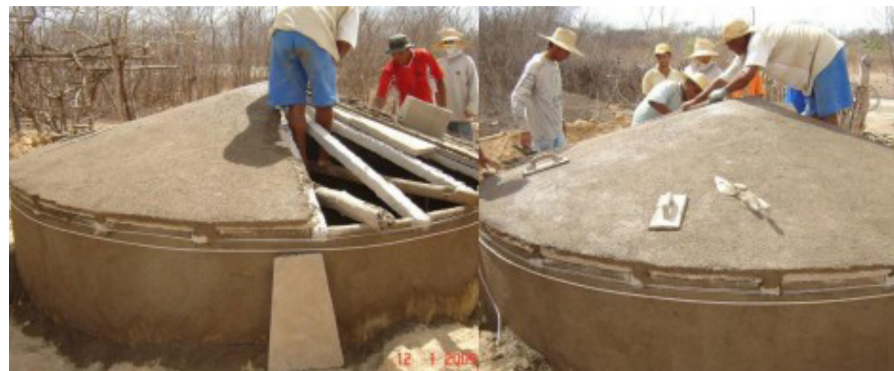
Figura 2 – Mutirão de construção de cisterna de placa em comunidade quilombola no Ceará. Fonte: Ministério do Desenvolvimento Social (2024). Disponível em: gov.br/mds.
