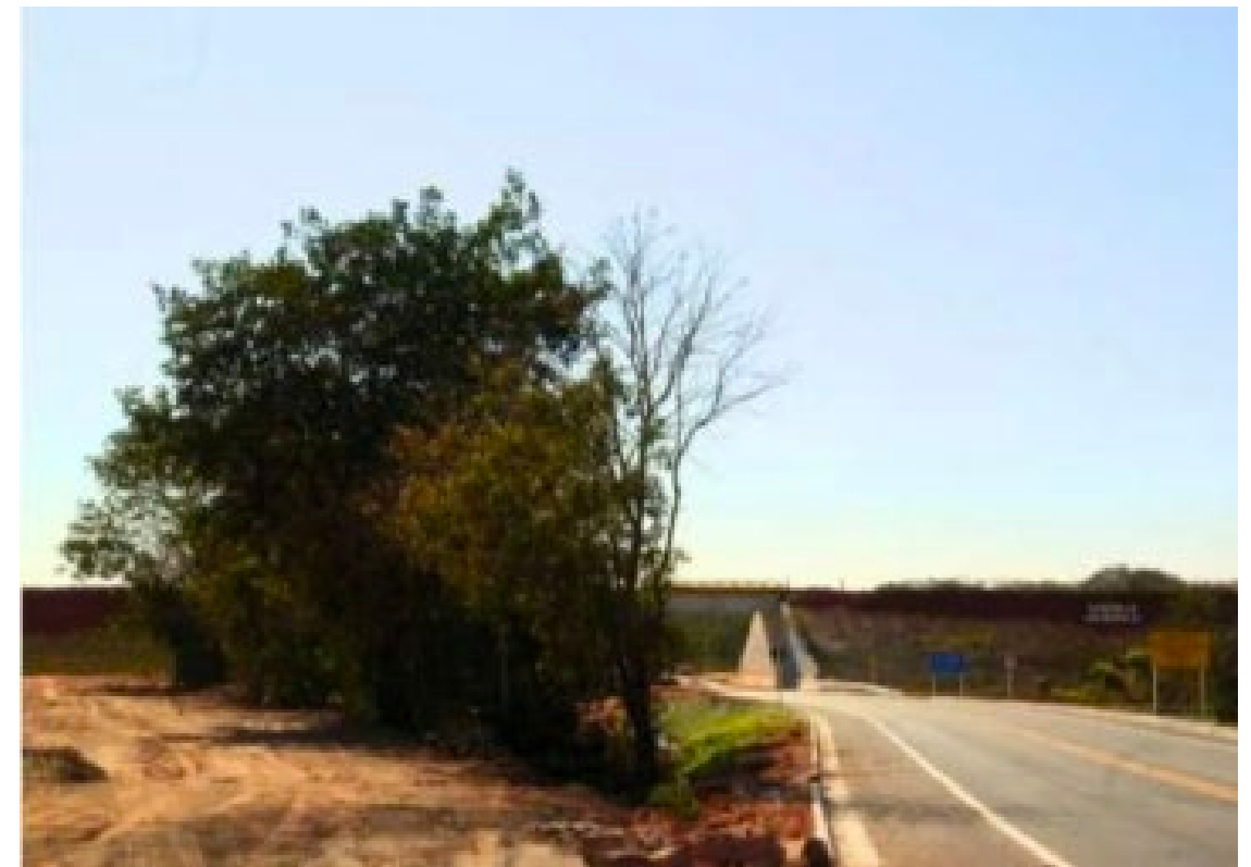
Figura 6 — Passagem ferroviária elevada cruzando Unidade de Conservação e rodovia — infraestruturas sobrepostas. Fotografias, 2025. Fonte: da Autora.
