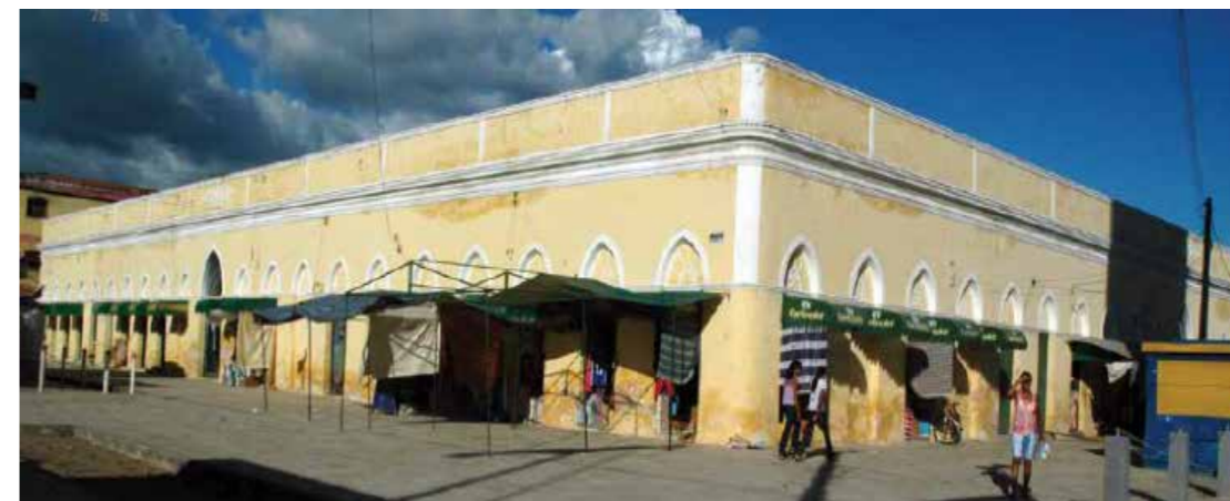
Figura 2 - Mercado Municipal de Penedo em Alagoas, com caráter de praça. Fonte: Revista IPHAN (2010).
