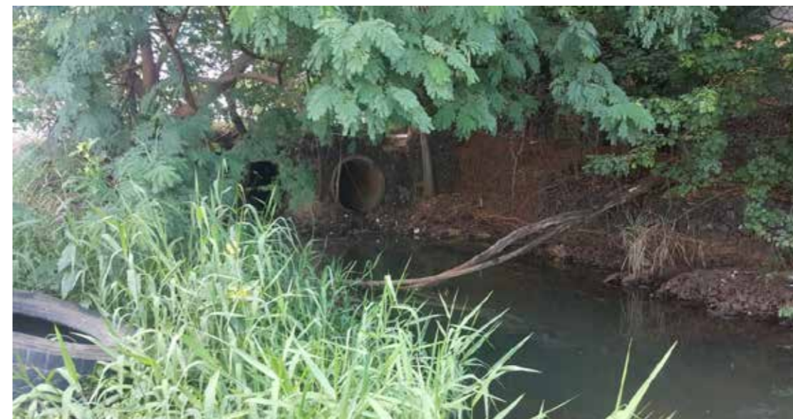
Figura 22 - Saída das galerias pluviais no Rio Paraná. Fonte: Bruno Vicente dos Passos e Nayara Leva, 2021.
