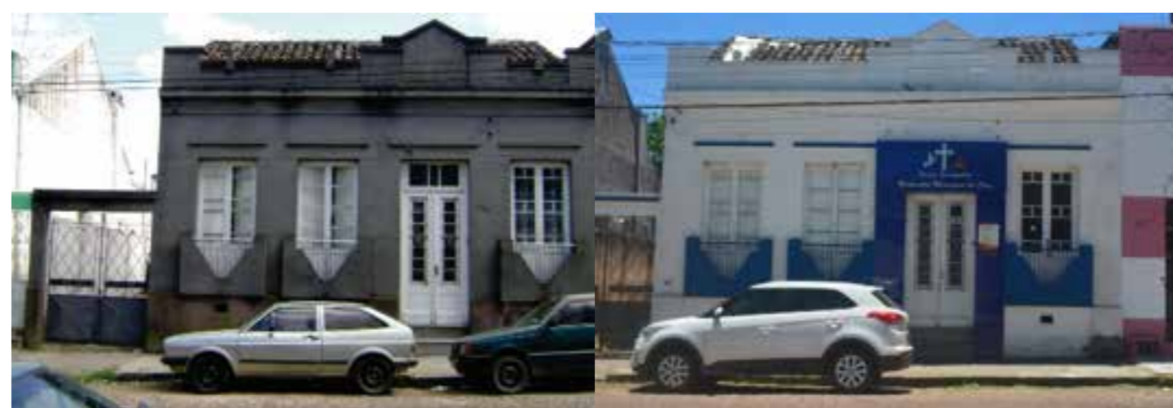
Figura 12 - Legenda das manifestações patológicas. Fonte: Autora, 2022. Figura 13 - Edificação 97-105 – Rua Barão do Amazonas, 105. Foto à esquerda constante no inventário com a fachada em cimento penteado e foto atual à direita com aplicação de pintura cobrindo o revestimento. Fonte: IPHAN, 2009 (esquerda) / Autora, 2021 (direita). Figura 14 - Edificação 55-249 – Rua Dr. Penna, 249. Foto à esquerda constante no inventário mostrando a fachada em cimento penteado e foto à direita atualmente com aplicação de pintura cobrindo o revestimento. Fonte: IPHAN, 2009 (esquerda) / Autora, 2021 (direita).
