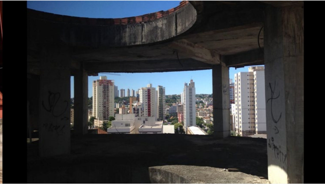
Figura 6 - Vista interna do edifício abandonado de Goiânia-GO enquadrando a paisagem. Fonte: Matheus de Paula Vaz Cândido Gomes, 2016.
