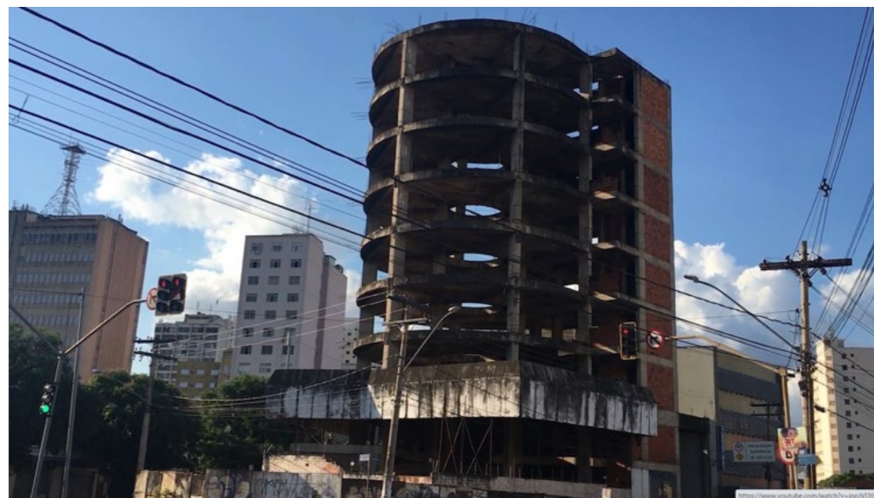
Figura 2 - Vista da estrutura inacabada abandonada e de seu entorno na região central da cidade de Goiânia-GO. Fonte: As autoras, 2020.
