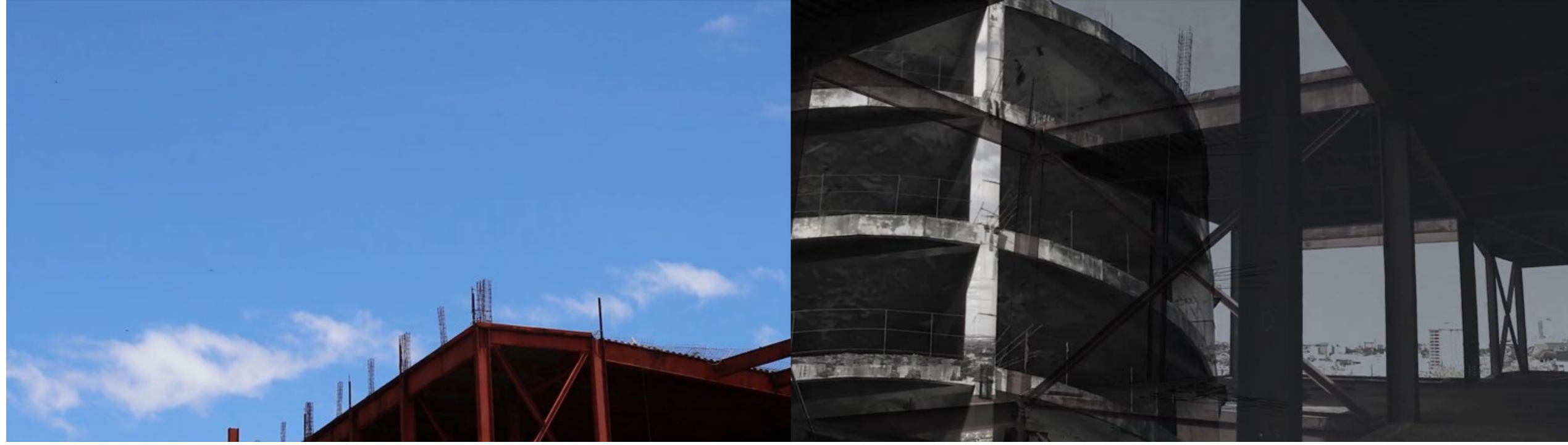
Figura 10 - Sobreposição de imagens dos dois edifícios inacabados e seu entorno. Fonte: As autoras, 2020.
