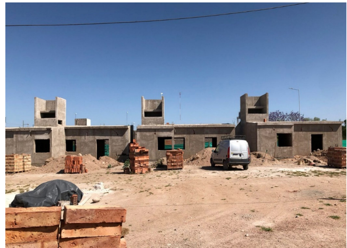
Figura 6 - Construção das primeiras unidades do Renacer I em La Rioja em Janeiro de 2024. Fonte: Fundava, 2024.
