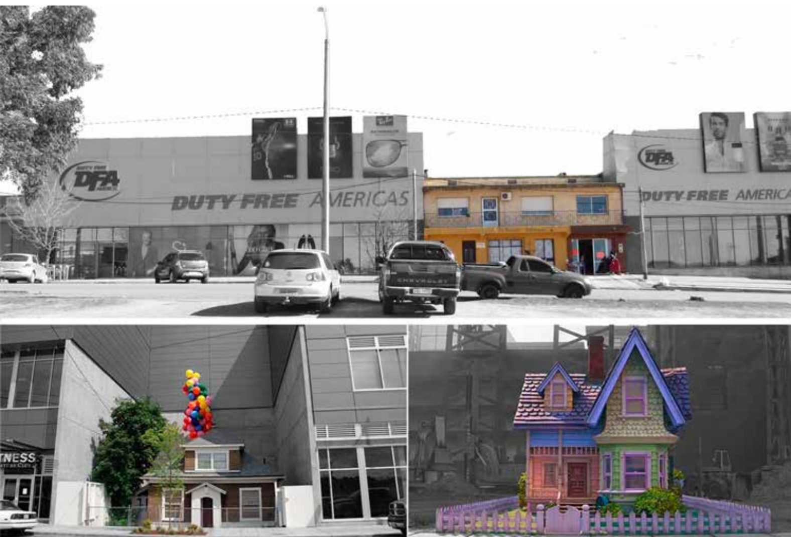
Montagem 3 - Em Aceguá (UY) um empreendimento de consumo “abraçou” o morador que resistiu ao mercado imobiliário, como ocorreu com a casa de Edith Macefield, em Seattle (abaixo a esquerda) e que inspirou o filme Up, Altas Aventuras (abaixo, a direita).
