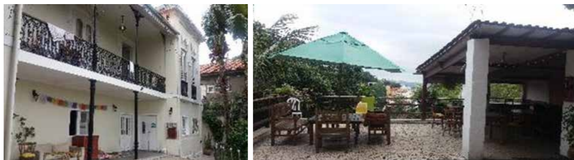
Figura 12 - À esquerda, a fachada posterior da Casa 02; à direita, a vista a partir do deck da Casa 02. Fonte: Autora (2018).
