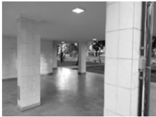
Figura 30: Pilotis de bloco da 409 N, por onde o OCD 7 passou. Figura 31: OCD 7 embarcando em ônibus na L2. Fonte: do autor, 2019.
