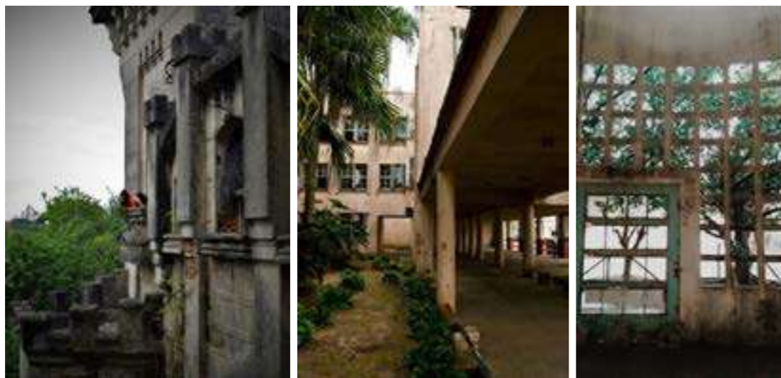
Figuras 7: (a) Castelo Simões Lopes Neto (b) interior do Edifício IPASE, em Pelotas (c) Antiga Caixa d'água de Pelotas. Fonte: dos autores, 2017.
