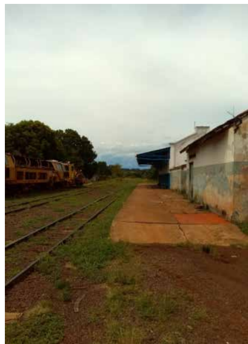
Figura 11 - Estação Ferroviária Atualmente. Fonte: Autora (2019). Figura 12 - Armazéns da Estação Ferroviária Atualmente. Fonte: Autora (2019).
