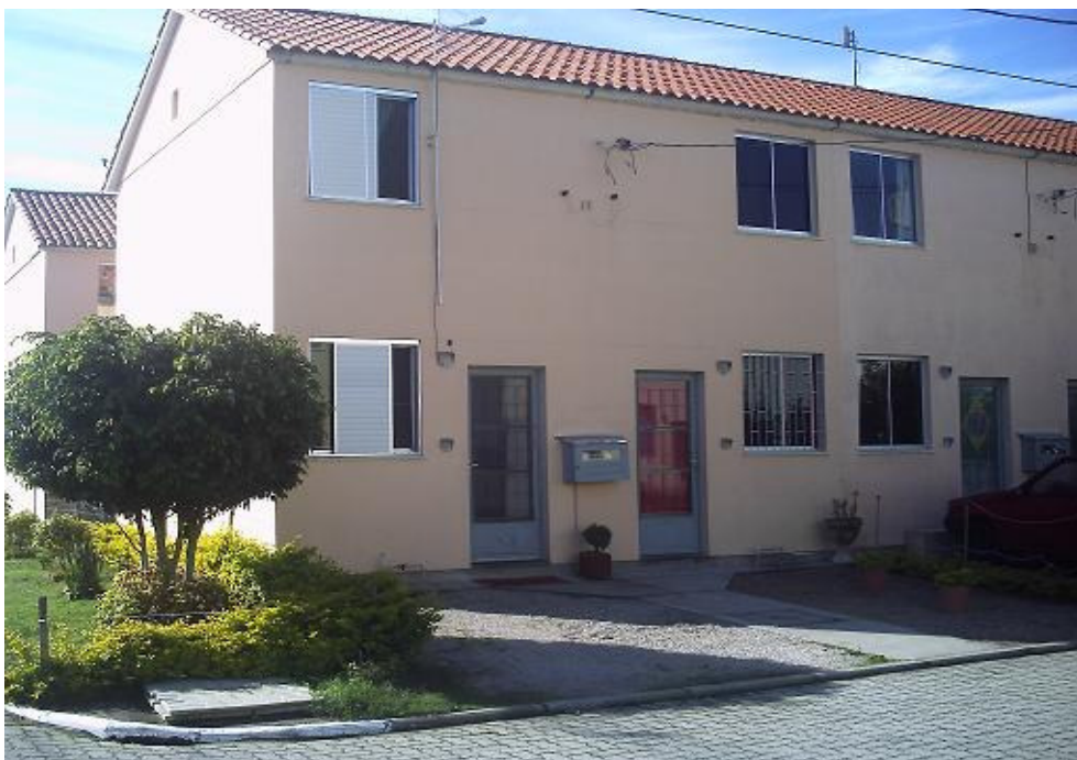
Figura 3 - Casa da moradora que colocou venezianas em suas janelas.
