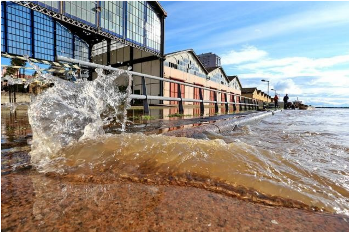
Figura 5: Pórtico do Cais Mauá alagado com as chuvas de Outubro de 2015. Fonte: < http://zh.clicrbs.com.br/rs/porto-alegre/noticia/2015/10/nivel-do-guaiba-atinge-maior-marca-em-74-anos-4876138.html > Acesso em: 12 Out. 2015
