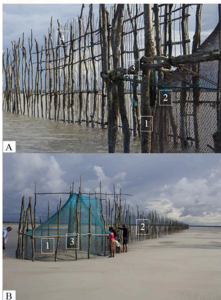
Figuras 3A: Partes do curral tipo enfiador da Vila do Mota: 1) Depósito, 2) Espia e 3) Boca. 3B: Componentes para a construção do curral. 1) Moirão, 2) Cintado, 3) esteira e 4) Tela.
