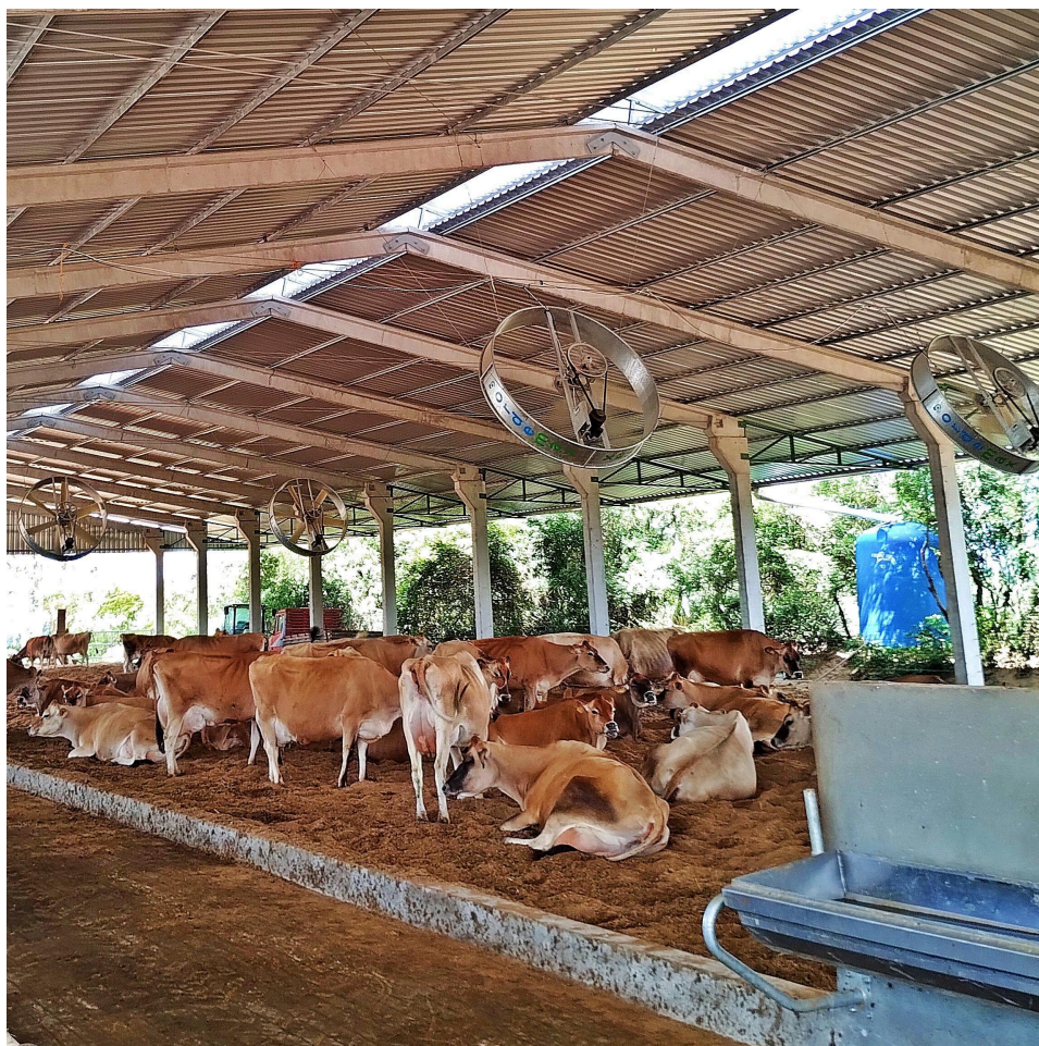
Imagem 3 - Sistema de confinamento do tipo Compost Barn com uso de ventiladores.
